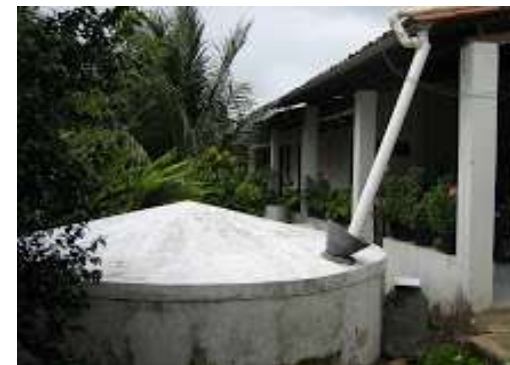
Captación de agua lluvia
